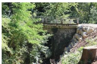
Les travaux de soutènement de la partie aval du pont qui consistaient à un enrochement de 15 ml sur une hauteur de 8 m afin de renforcer une pile du pont sont terminés.
