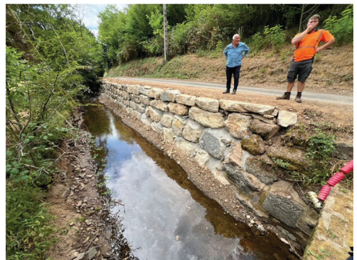
Enrochement impasse du Moulin du Sapinier
